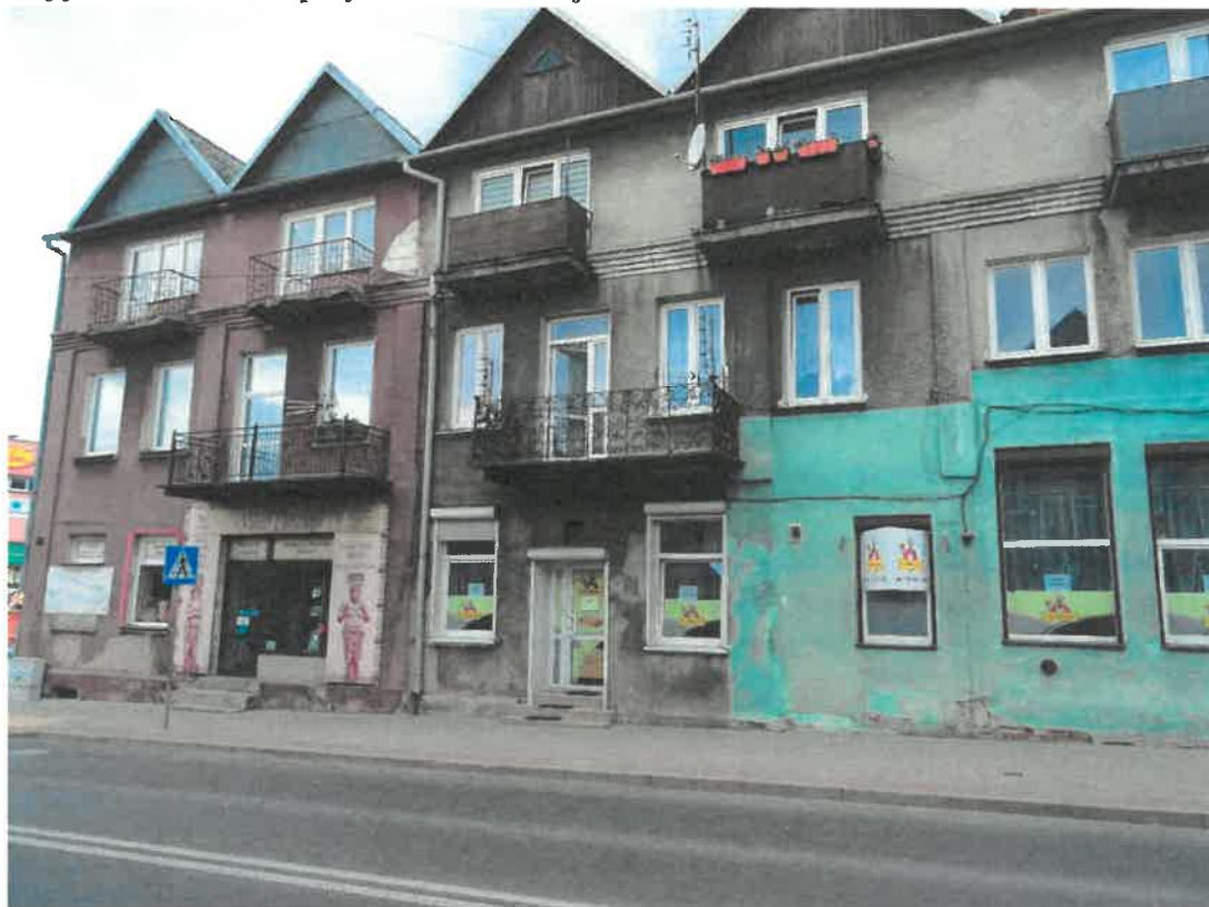
Zdjęcie 7. Kamienice przy ul. Białostockiej
