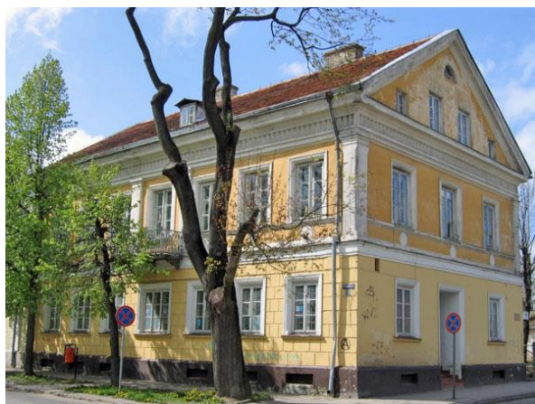
Budynek kamienicy w Sokółce przeznaczony do remontu
