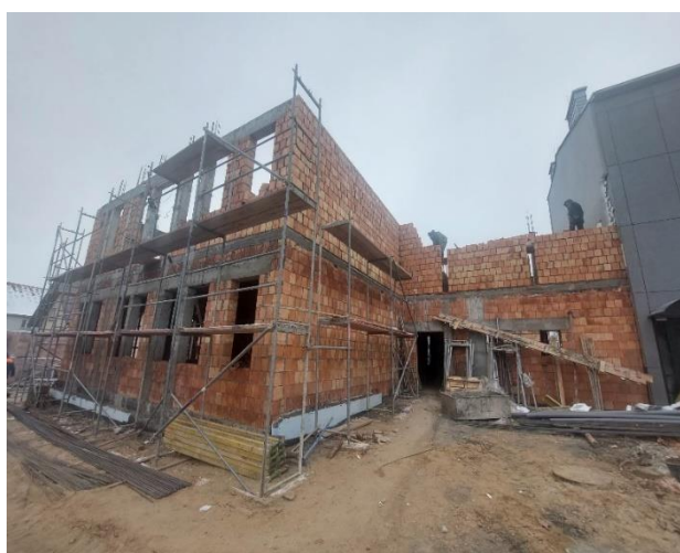
Budowa budynku biblioteki
