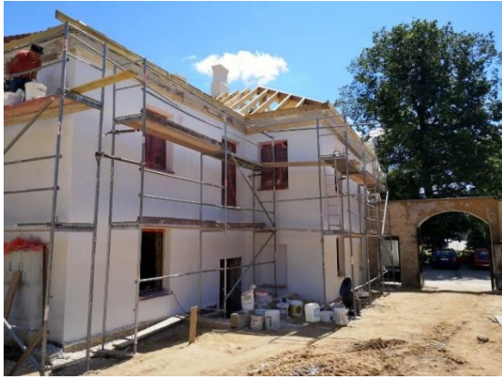
Budynek w trakcie przebudowy
