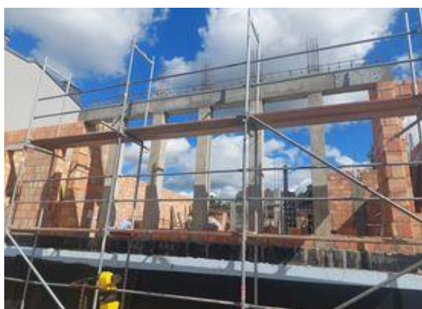
Budowa budynku biblioteki
