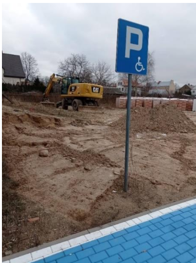
Budowa budynku biblioteki
